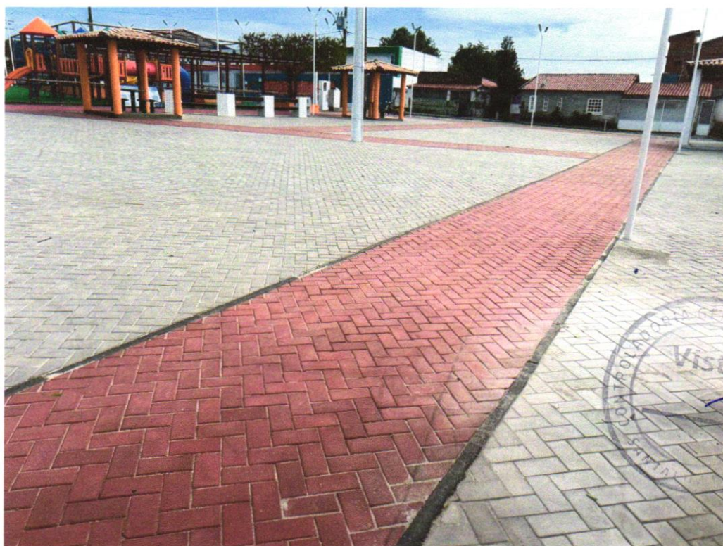
Foto 04 – Pavimentação em bloco de concreto vibroprensado, intertravado, cor natural, 10x20cm, e=6cm, 46un/m 2 , NBR9781, Fck(min)=35MPa, sob coxim areia grossa compactada c/ placa vibratória, e(comp.)=6cm, rejuntado c/ areia fina.
