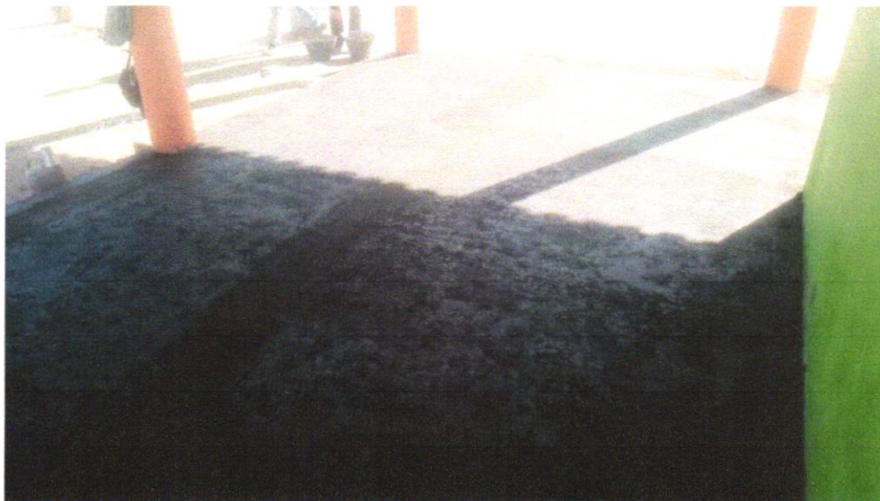
Foto 03 – PAVIMENTAÇÃO EM CONCRETO, COM ESPESSURA DE 7 CM, COM ACABAMENTO FEITO UTILIZANDO ALISADORA DE CONCRETO (HELICOPTERO), INCLUIDO TELA DE AÇO SOLDADA NERVURADA CA60, Q196 (3,11 KG/M 2 ), DIAMETRO DO FIO 5.0 MM, LARGURA = 2,45 M, ESPAÇAMENTO DA MALHA = 10 X 10 CM, JUNTA DE DILATAÇÃO EM PVC A CADA 2,00 M, CONCRETO FCK = 20 MPA
