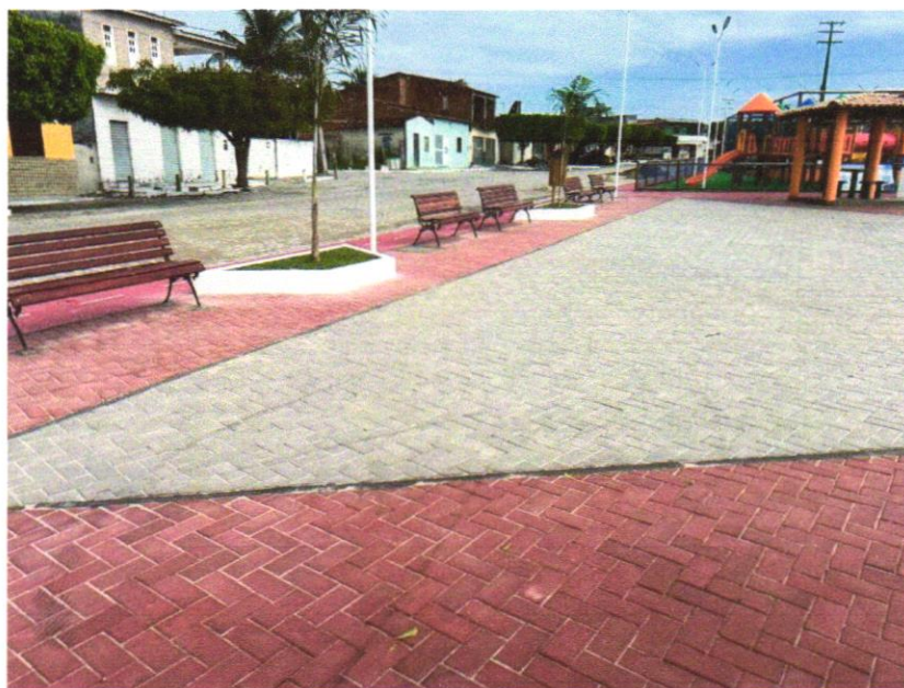
Foto 05 - Pavimentação em bloco de concreto vibroprensado, intertravado, colorido, 10x20cm, e=6cm, 46un/m2, NBR9781, Fck(min)=35MPa, sob coxim areia grossa compactada c/ placa vibratória, e(comp.)=6cm, rejuntado c/ areia fina.
