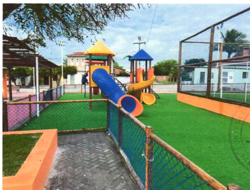
Foto 06 - FORNECIMENTO E MONTAGEM DE CERCA DE PROTEÇÃO EM EUCALIPTO CLOEZIANA TRATADO A BASE DE CCA EM AUTOCLAVE, COM APLICAÇÃO DE STAIN NA COR NATURAL COM DUPLO FILTRO SOLAR, DIÂMETRO DO EUCALIPTO DE 6 A 8 CM, COM ANTI-RACHA NA EXTREMIDADE. FECHAMENTO COM TELA DE ALAMBRADO FIO Nº 12 REVESTIDO DE PVC, MALHA 2.1/2 X 2.1/2", FIXADO COM FIO Nº 14 REVESTIDO EM PVC, MÓDULO MEDINDO 1,50 X 1,00M, PARAFUSOS GALVANIZADOS COM TRAVAMENTO CLICKFIX, CONFORME PROJETO
