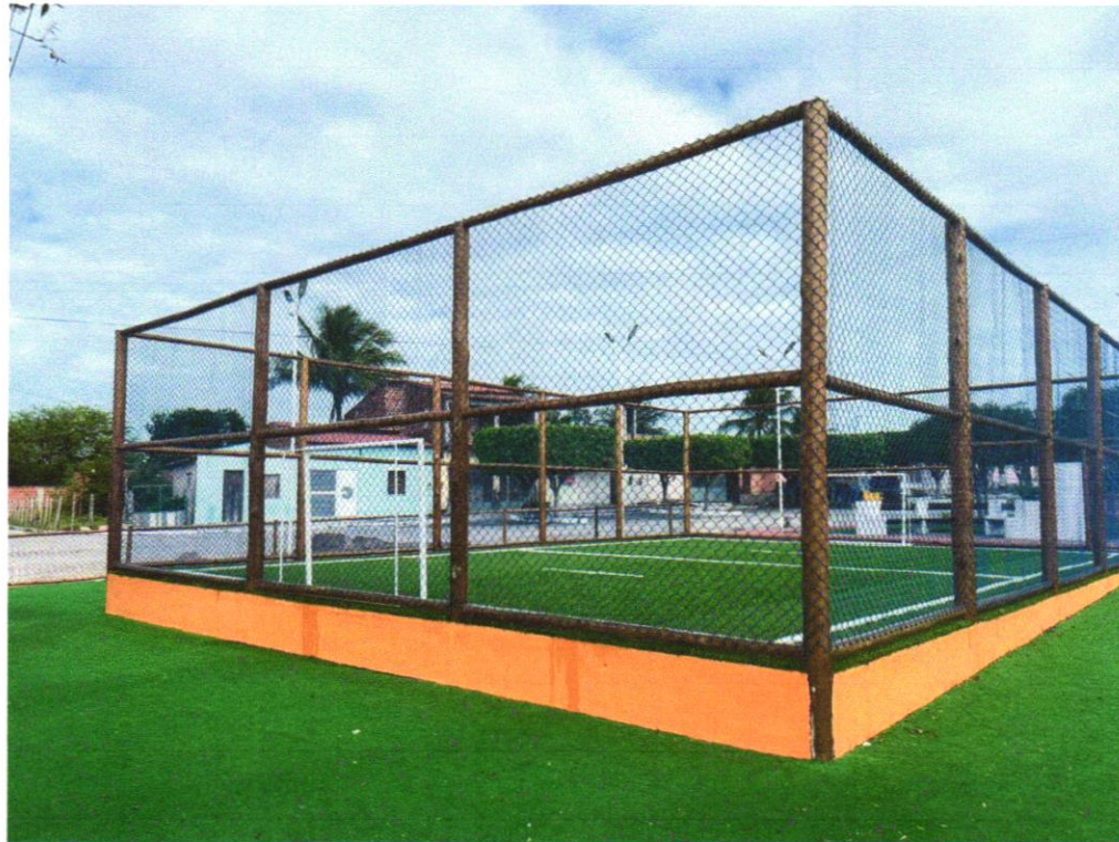
Foto 09 - FORNECIMENTO E INSTALAÇÃO DE GRAMA SINTÉTICA COM ALTURA MAIOR OU IGUAL A 20 MM
