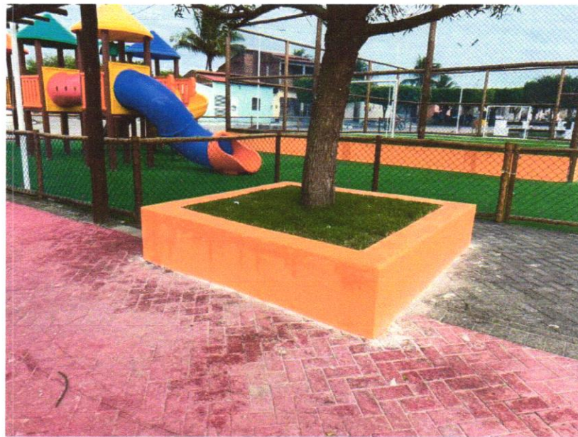
Foto 01 - MASSA ÚNICA, PARA RECEBIMENTO DE PINTURA, EM ARGAMASSA TRAÇO 1:2:8, PREPARO MANUAL, APLICADA MANUALMENTE EM FACES INTERNAS DE PAREDES, ESPESSURA DE 10MM, COM EXECUÇÃO DE TALISCAS
